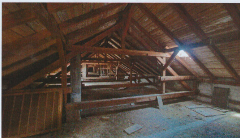
Slika 2. Kosi krov objekta
